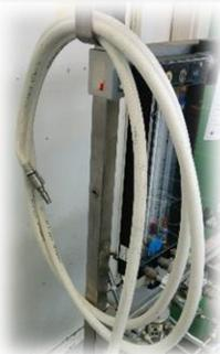
As tubagens flexíveis ligam a saída do terminal (na tomada de parede) à torre anestésica.
