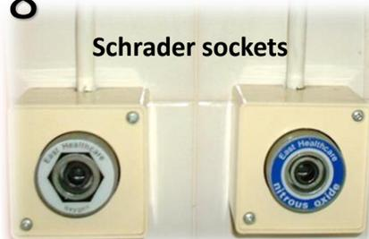
Existem clínicas e hospitais que utilizam um sistema de gasoduto (conduta). O gás canalizado é retirado de uma fonte central e introduzido numa rede de distribuição de gasodutos etiquetada e codificada por cores que termina em tomadas de parede auto-bloqueantes - tomadas **Schrader**.
