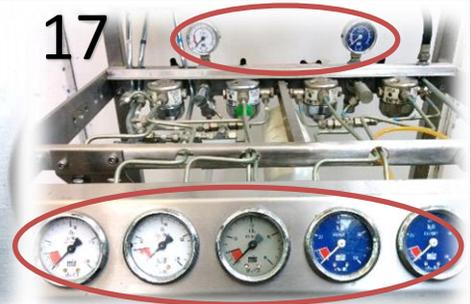
Nesta torre/máquina, os manómetros podem ser identificados tanto para os cilindros como para a alimentação da tubagem.
